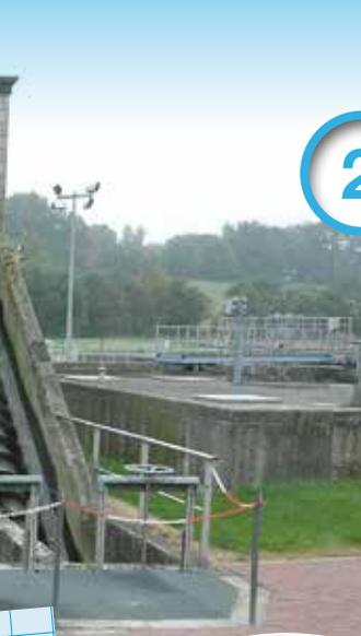
**L**es eaux usées transportées par les égouts puis par les collecteurs arrivent généralement à la station d'épuration à des profondeurs pouvant aller jusqu'à 5 mètres, voire plus ! Pour cette raison, un relevage est nécessaire à l'entrée de la station.
